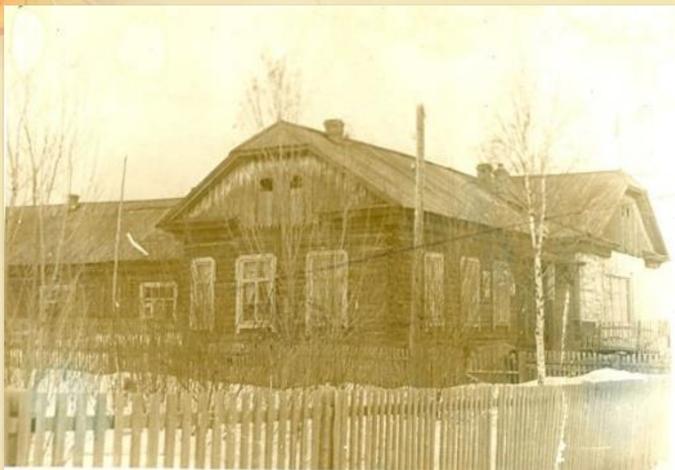
Общий вид здания Перегребинской школы. с. Перегребное. [1970-1980 годы].
